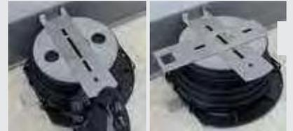
D-3. Den Clip SUPACLPT senkrecht zur Wand positionieren. Den Clip für den Kopf SUPACLPT positionieren.
