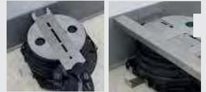
D-3. Den Randabstandshalter SUPACLPP und das Profil BSJ auf dem Kopf des Stelzlagers positionieren.
