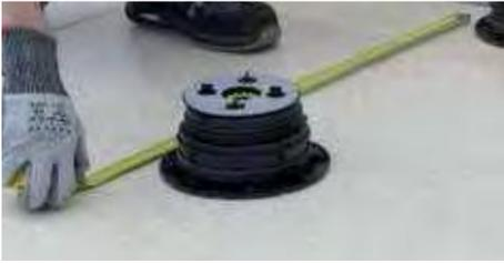
12. Die Mitte der Stelzlager entsprechend der Plattengröße positionieren.
