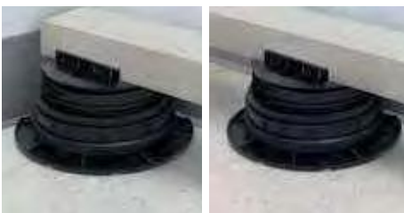
19. Den Holzbalken, der auf dem Flügel SUPAW aufliegt, positionieren.
