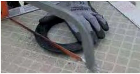
17. Die Basis umdrehen und eine der Seiten entlang der vorgeprägten Linie entfernen.
