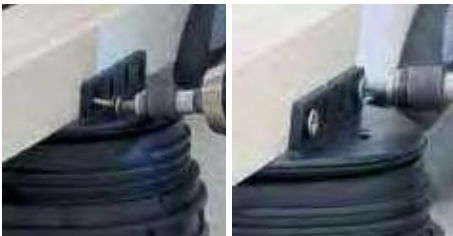
13. Den Balken am Träger mit den vorgesehenen Schlitzte anschrauben.
