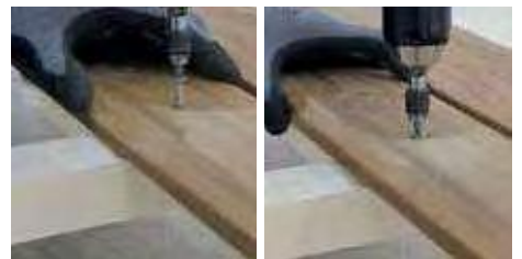
24. Die Holzdielen am darunter liegenden Holzbalken mit einem Schraubendreher anschrauben.
