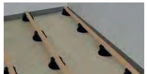
21. Überprüfen, dass der Balken fest mit jedem Träger verbunden ist.
