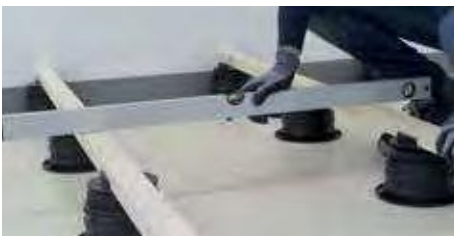
22. Überprüfen, dass die Installation nivelliert ist.
