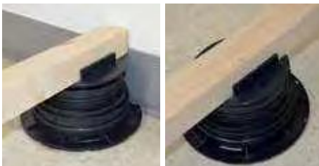
12. Den Holzbalken, der auf dem Flügel SUPAW aufliegt, positionieren.
