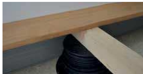
23. Die erste Holzdielen an der Wand anlegen.
