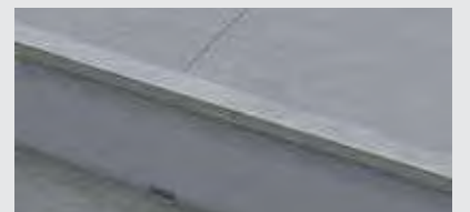
E-6. Die Platte zur Abdeckung verlegen.
