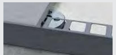
E-3. Die Platte zur Abdeckung verlegen.
