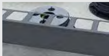
E-2. Das Profil BSR zwischen den Abstandhaltern auf dem Kopf des Stelzlagers positionieren.
