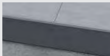
E-4. Die Platte zur Abdeckung verlegen.
