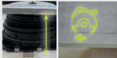
E-4. Die Platte entsprechend dem Abstand zwischen dem Profil BSJ und dem Clip SUPACLPB zuschneiden.
