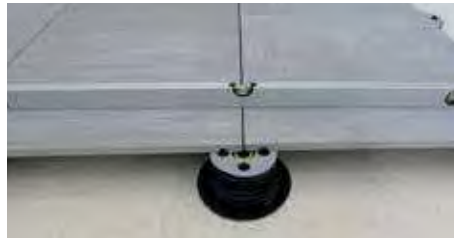
16. Überprüfen, ob der Bodenbelag gerade ist.
