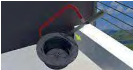
1. Eine der Trägerseite abschneiden.
