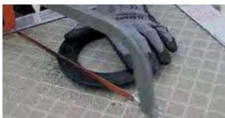
7. Das Basisteil umdrehen und an einer Seite entlang der Perforierung abschneiden.
