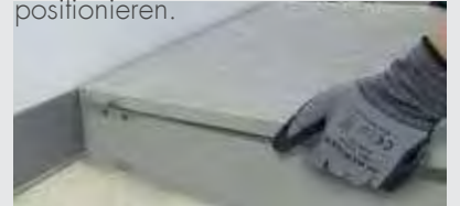
D-6. Die Platte zur Abdeckung verlegen.
