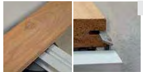
20. Die erste Reihe Holzdielen verlegen und dabei die Öffnung im Clip SUPCLIP einrasten.
