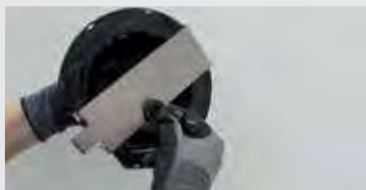
E-1. Den Clip SUPACLPB unter dem Basisteil des Stelzlagers positionieren.
