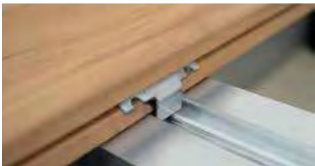
21. Einen Clip SUPCLIP zur Blockierung der Dielen positionieren.
