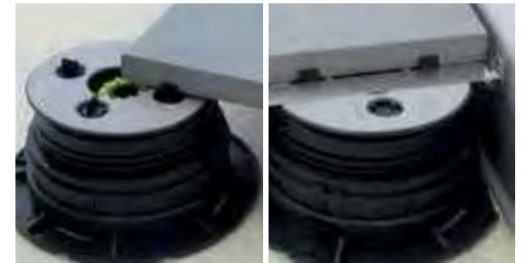
14. Die Eckpunkte der Platte zwischen den Abstandshaltern ablegen.
