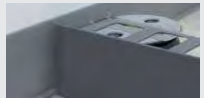
D-3. Das BSR-Profil auf den Trägerkopf positionieren.
