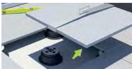
1. Die betroffene Fliese anheben.
