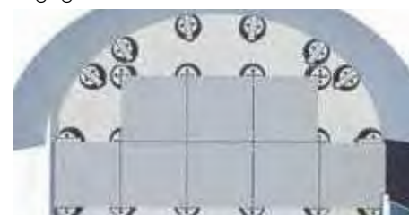
14. Die ganzen Fliesen nach dem Verlegungsschema positionieren.
