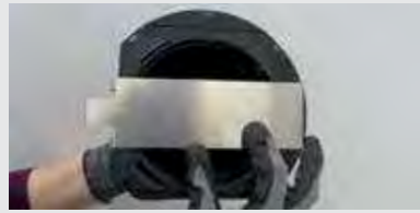
D-1. Den Clip SUPACLPB unter dem Basisteil des Stelzlagers positionieren.
