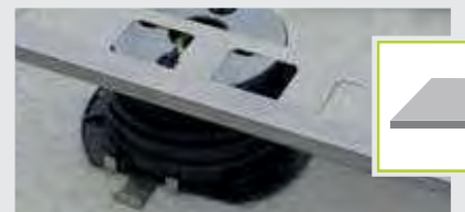
E-3. Das Profil BSJ auf dem Kopf des Stelzlagers positionieren
