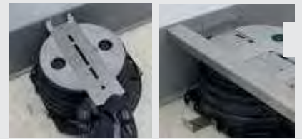
D-3. Den Randabstandshalter SUPACLPP und das Profil BSJ auf dem Kopf des Stelzlagers positionieren.
