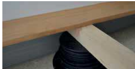
23. Die erste Holzdielen an der Wand anlegen.
