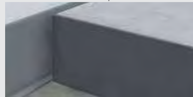
D-4. Die Platte zur Abdeckung verlegen.
