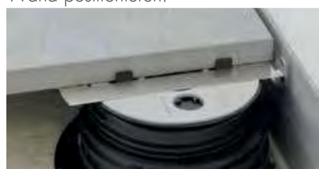
11. Die Platte verlegen.
