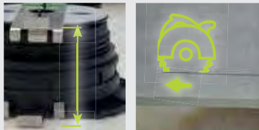
E-4. Die Platte entsprechend dem Abstand zwischen den Clips SUPACLPT und SUPACLPB zuschneiden.
