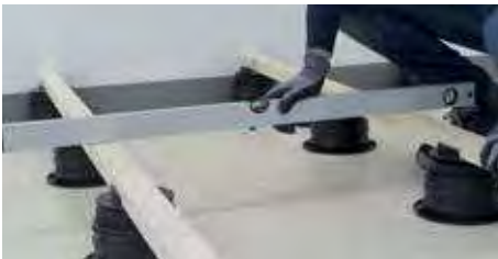
22. Überprüfen, dass die Installation nivelliert ist.
