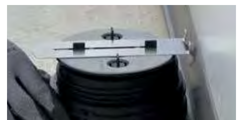
9. Den Randabstandshalter SUPACLPP zwischen den Abstandshaltern des Stelzlagers und mit Kontakt zur Wand anbringen.
