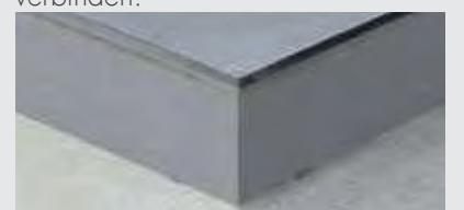
F-6. Die Platte zur Abdeckung verlegen.
