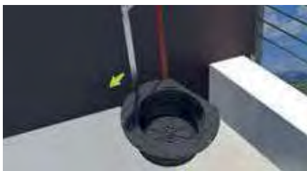
10. Beide Seiten des Trägers abschneiden.
