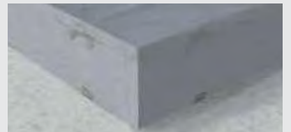
F-6. Die Platte zur Abdeckung verlegen.
