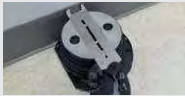
D-2. Den Abstandhalter-Clip SUPACLIP auf den Trägerkopf positionieren.
