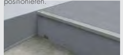
D-6. Die Platte zur Abdeckung verlegen.
