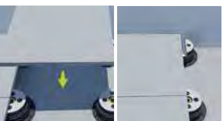
7. Die Fliesen verlegen.
