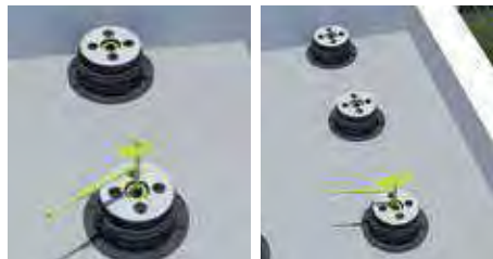
5. Die restlichen Träger positionieren und den Kopf durch Anschrauben des Rings feststellen.
