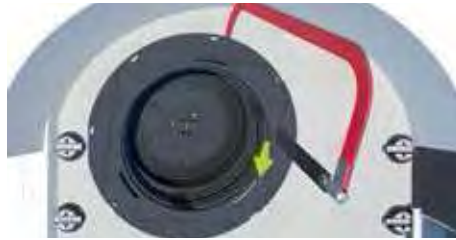
5. Eine der Trägerseite abschneiden.
