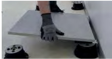
13. Die Platte verlegen.
