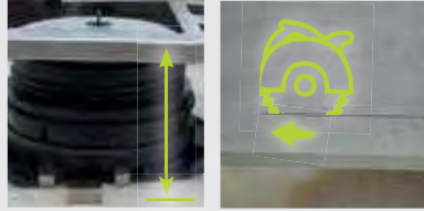
D-4. Die Platte entsprechend dem Abstand zwischen dem Profil BSJ und dem Clip SUPACLPB zuschneiden.
