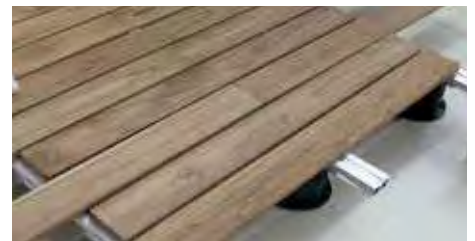
23. Alle Holzdielen verlegen und dabei die Öffnung im Clip SUPCLIP einrasten.
