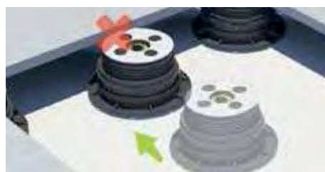
2. Den Träger auf die Höhe der umliegenden Fliesen bringen, um die Höhe korrekt zu verändern.
