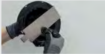
D-1. Den Clip SUPACLPB unter dem Stelzlager positionieren.
