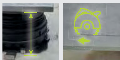
F-4. Die Platte entsprechend dem Abstand zwischen dem Profil BSJ und dem Clip SUPACLPB zuschneiden.
