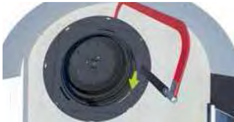
1. Eine der Trägerseite abschneiden.
