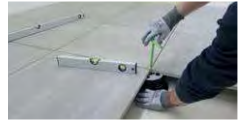
17. Im Falle einer Abweichung die Höhe mit dem Schlüssel SUPAK nachjustieren.
